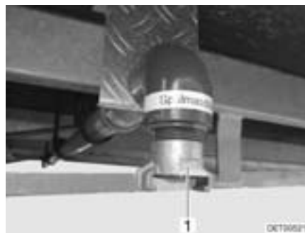
Bild 18 Abwasseranschluss für Spülmaschine
