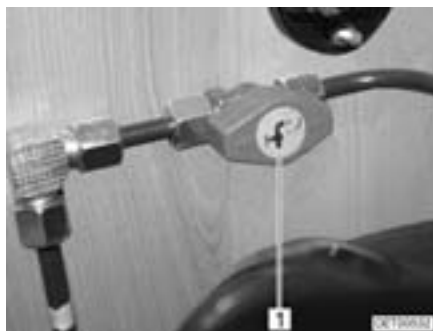
Bild 44 Symbol auf dem Gasabsperrentil
