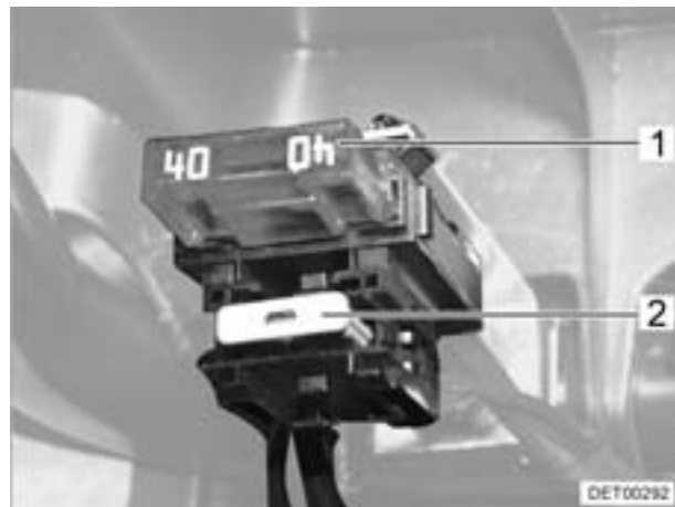
Bild 119 Sicherungen an der Wohnraumbatterie
