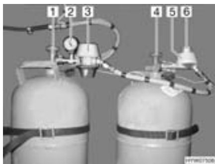
Bild 132 Duomatic-Umschaltanlage
