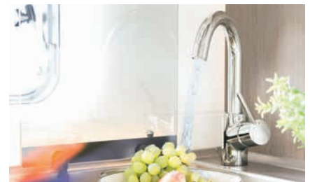
» Dank der Druck-Wasseranlage mit Festwasseranschluss fließt das Wasser in Küche und Bad mit Hochdruck
